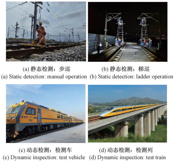
图 3 接触网静/动态检测
