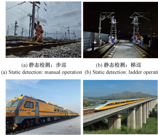
图 3 接触网静/动态检测
