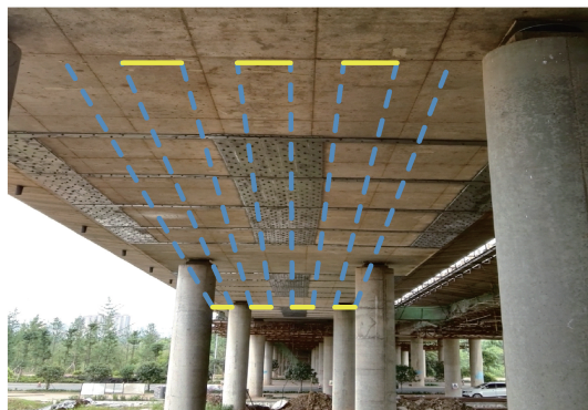
图3 桥梁检测机器人“长纵短横”循环采集模式
