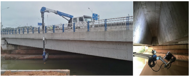
图 16 桥梁检测机器人应用工作现场
