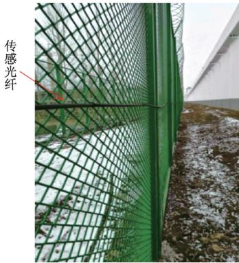
图4 语音信号测试户外布线效果
