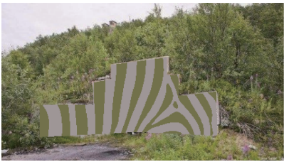
图 17 洞库口部直接映射的斑马纹伪装图案(起始代, 条纹与底色 RGB 三分量分别为[113,116,69]、[168,158,154])
