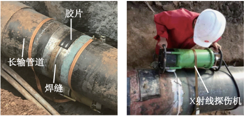
图 4 管道焊接数据现场采集过程
