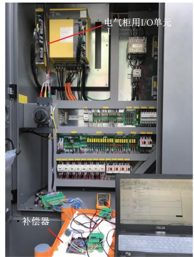
图 24 外挂式误差补偿器接线图
